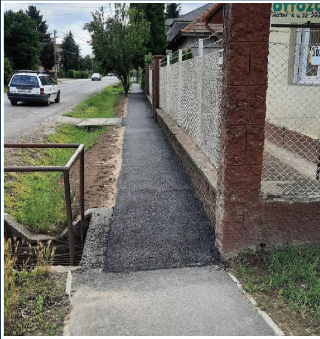
Járdafelújítás a Dózsa György úton, a Pacsirta utcától az Ady Endre utcáig terjedő szakaszon.
