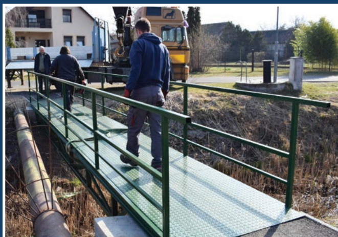
Hartyán -patak és Sződ Rákos-patak hídjainak megépítése: - Önerős beruházás: Br: 2.000.000 Ft
