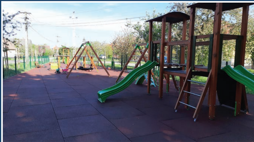
Játszóter építése a Szödi Hősök terén:
