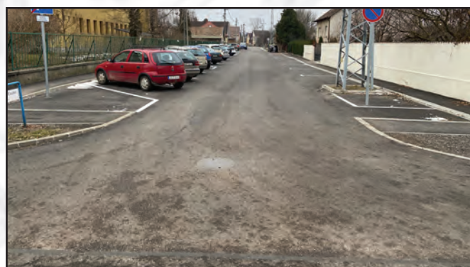
Ady Endre utca felújítása
